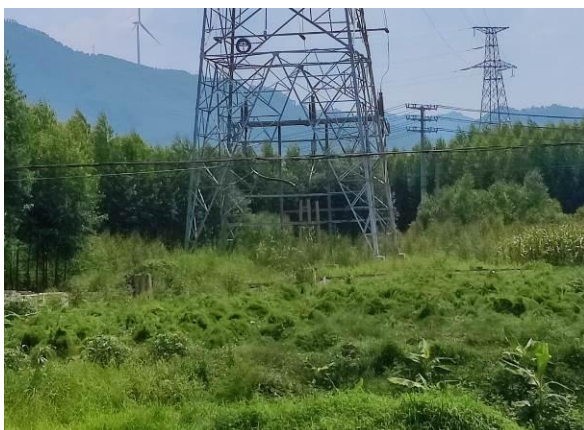
铁塔恢复现状 (4)
