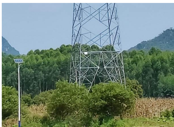
铁塔恢复现状 (3)
