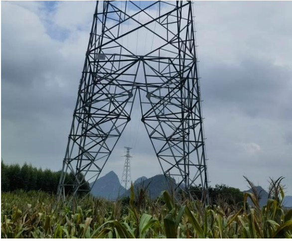
铁塔恢复现状 (7)
