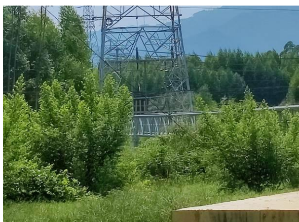
铁塔恢复现状 (5)
