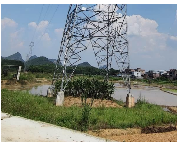
铁塔恢复现状 (2)
