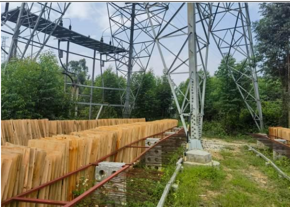
铁塔恢复现状 (11)
