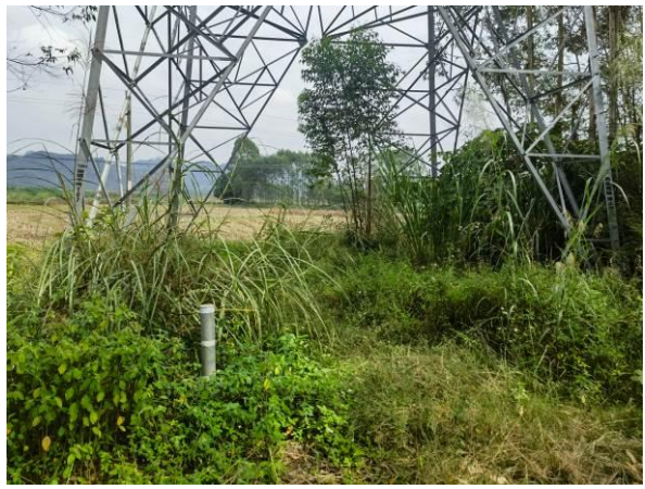
铁塔恢复现状 (10)
