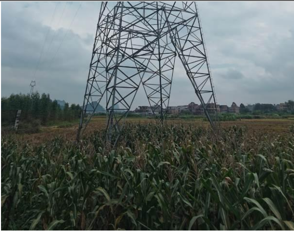
铁塔恢复现状 (9)
