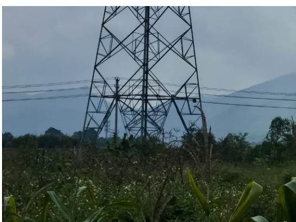
铁塔恢复现状 (6)
