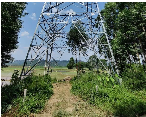
铁塔恢复现状 (1)
