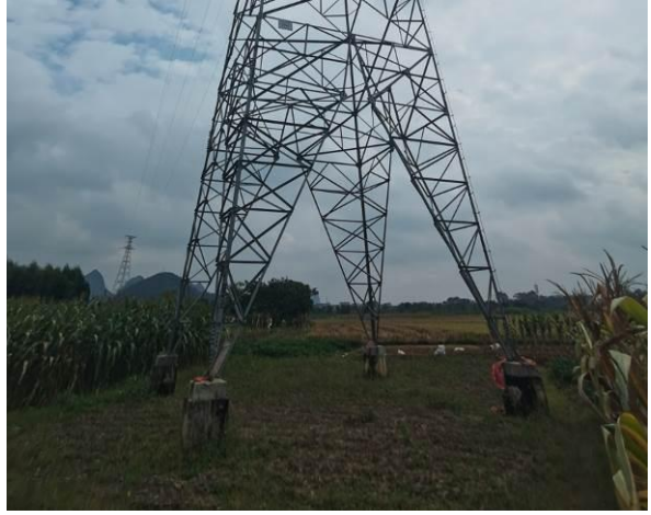
铁塔恢复现状 (8)
